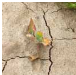
11 nappal a permetezést követően
