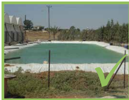
Îngrădiți spațiul sau blocați prin alte mijloace accesul la rezervoare, șanțuri sau canale cu apă.
